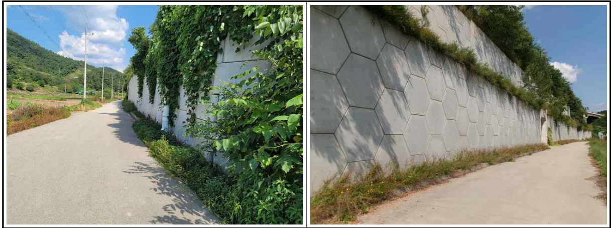
【사진 12.3.1】 지반, 기초부 전경
