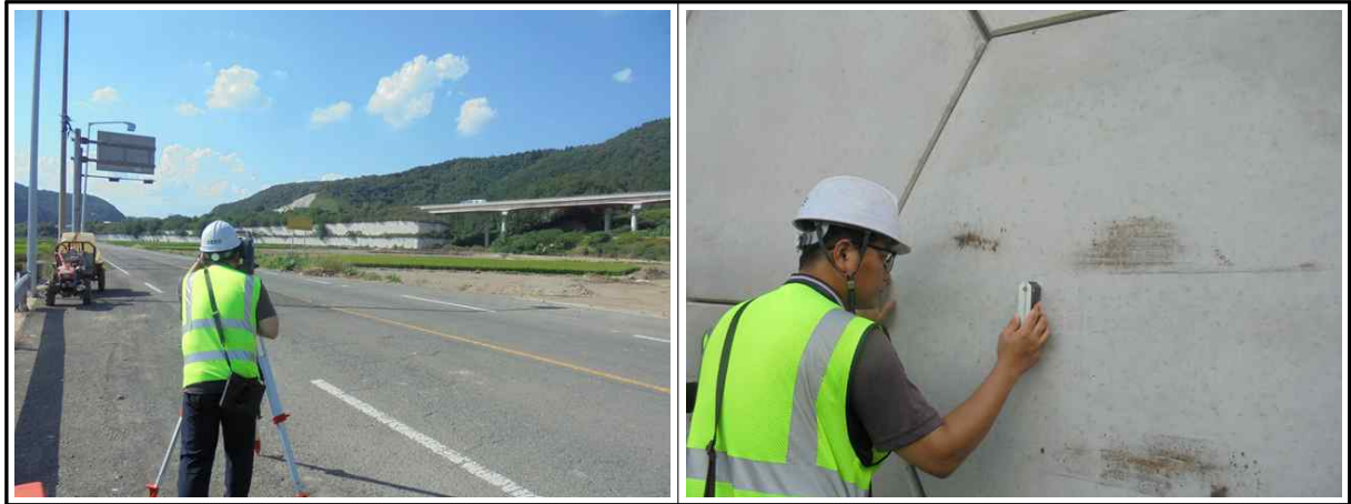
【사진 12.4.2】 측량작업 전경
