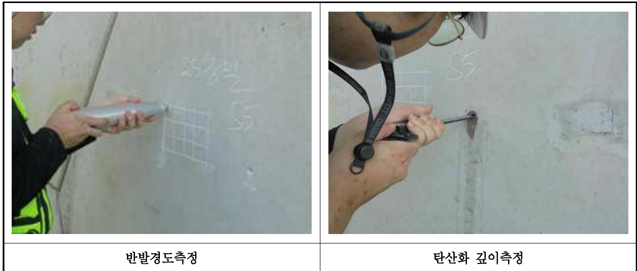
【사진 12.4.1】 재료시험 조사 전경
